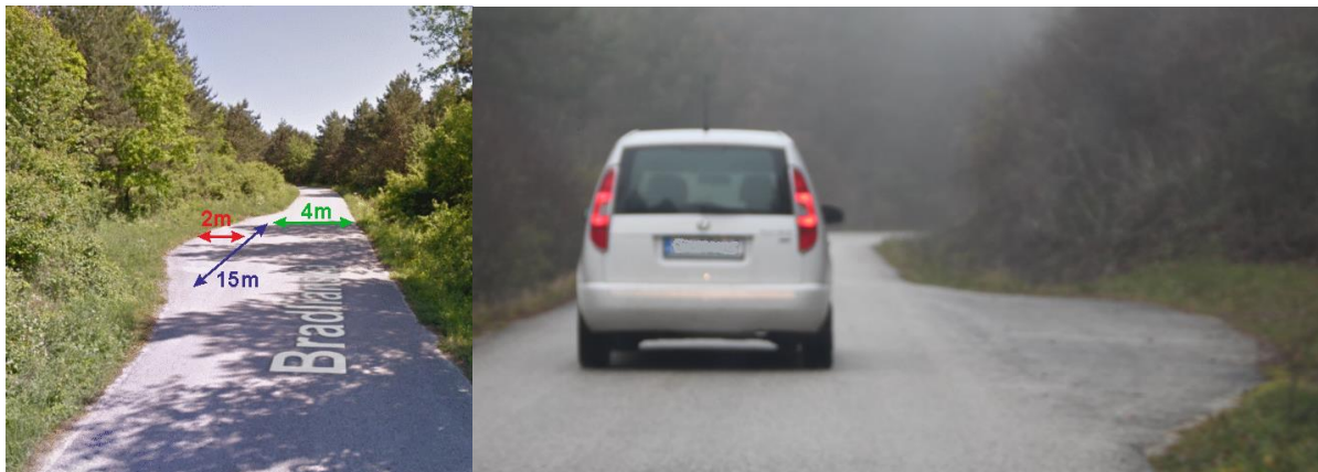
Obr. 1.1.7 Znáznornenie 4. výhybne v smere na Bradlo, (na obrázku vpravo je výhybňa znázornená v smere z Bradla); Zdroj: googlemaps, autor
