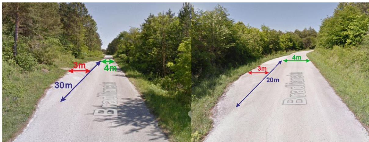
Obr. 2.4.11 Znázornenie súčasného stavu 1. výhybne (vľavo) a 5. výhybne (vpravo); Zdroj: googlemaps, autor
