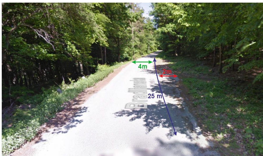
Obr. 1.1.9 Znárodnenie 6. výhybne v smere na Bradlo; Zdroj: googlemaps, autor
