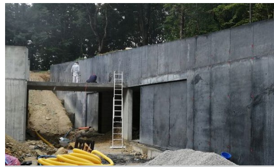
Výstavba Infobodu na Bradle
