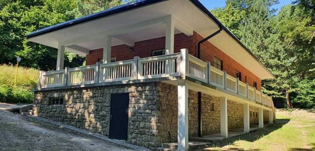
Zrekonštruovaná Strážnica (Chata na Bradle)
